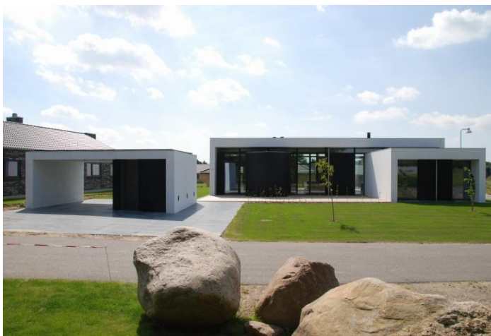
Figur 8 Testhuset "Villa Vid" i Århus (klasse 2020) er opført med præfabrikerede vægelementer fra Connovate med U-værdi 0.083 \text{ W/m}^2 \cdot \text{K} – vægtykkelsen er 35 cm. sandwich elementbaseret på højstyrkebeton og PUR-skum fra det danske firma Connovate
