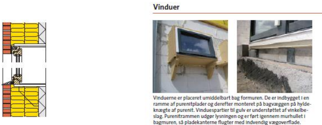
Figur 13 Indbygning af indadgående vindue bag formur – brug af purenit – Stenagervænget 28 i Komforthus-projektet. [13]
