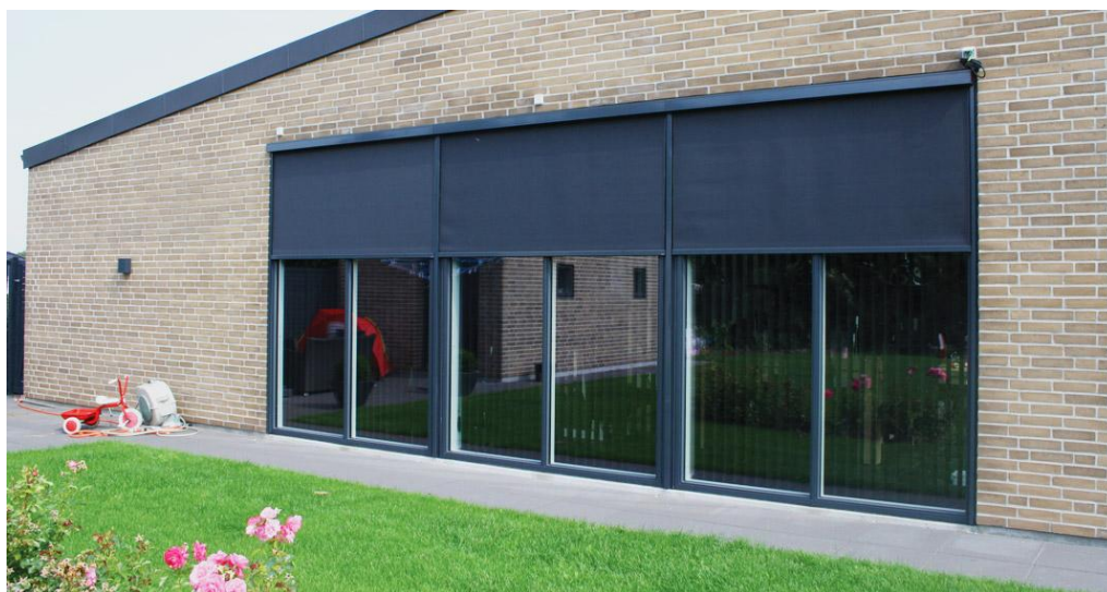
Figur 27 Eksempel på udvendig automatisk solafskærmning som screens. [32]
