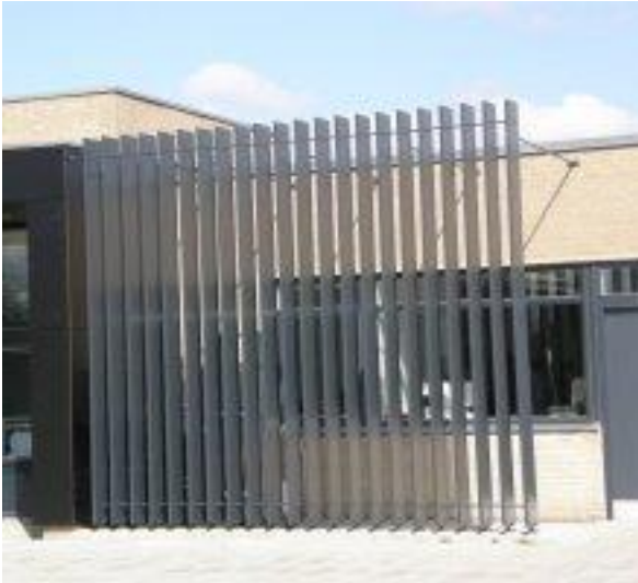
Figur 25 Lodrette lameller anvendes på øst- og vestvendte facader.[31]
