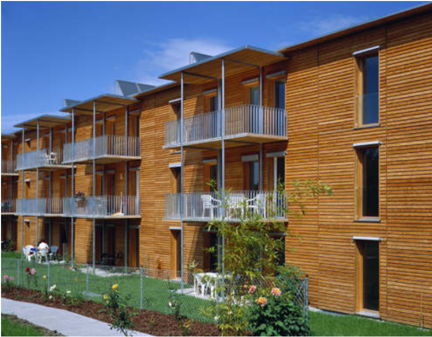
Figur 7.14 Vestfasade. Man skimter solfanger-installasjonene på taket
