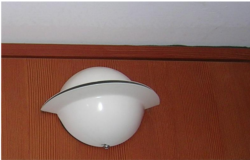
Figur 4.30 Tilluftsventil type: "Frog mouth" ("froskemunn") som brukes mye i passivhus med kun luftoppvarming.
