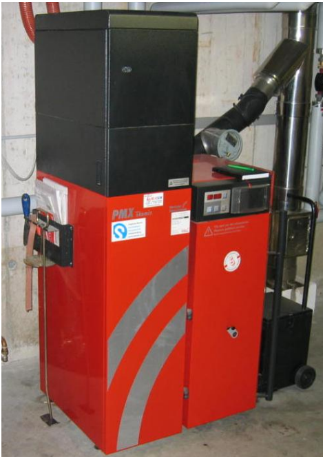
Figur 4.31 Sentral biopelletskjel som produserer varme til tappevann og romoppvarming i et passivhusprosjekt i Østerrike.
